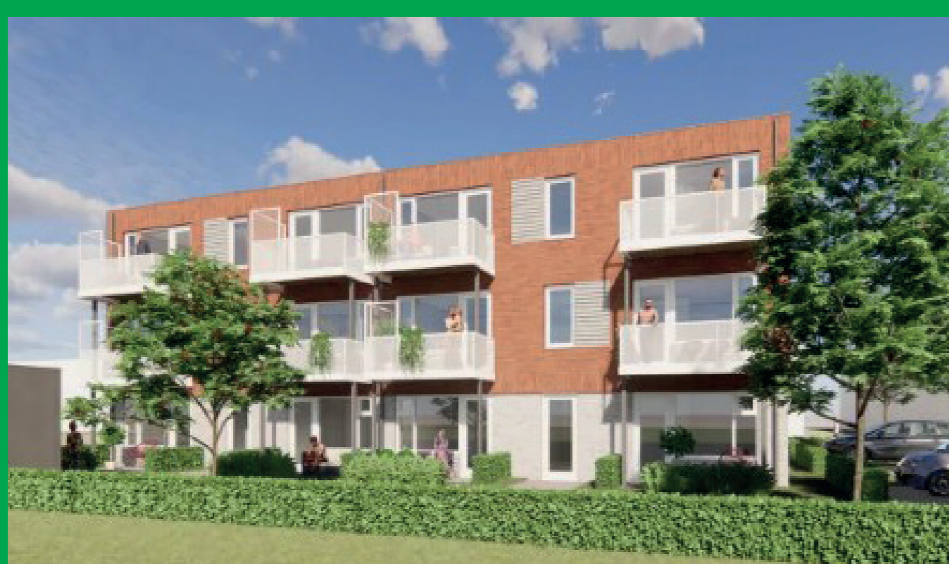
85 nieuwe sociale huurwoningen
